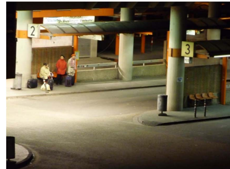
Fernbusbahnhof Köln, Foto: WDR, Kcw
